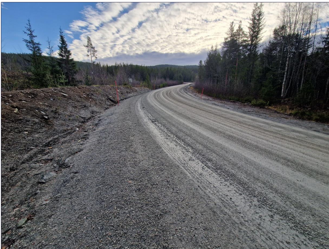
Figur 8 Topplek med sortert løsmasse der grusinnholdet er vesentlig større enn for de knuste massene.
