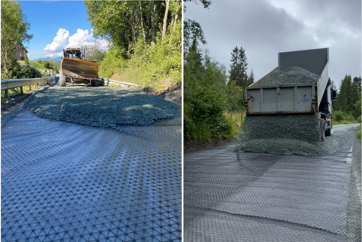
Figur 11. Utlegging av bærelag over fiberduk og geonett.
