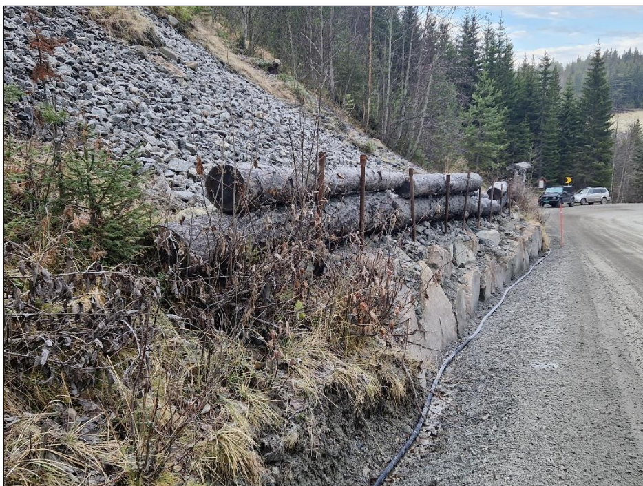
Figur 14. Dagens sikring av skråning
